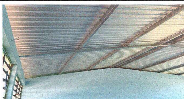
Foto 2: SE OBSERVA LAS LAMINAS PORTANTES DEL MODULO 2,
