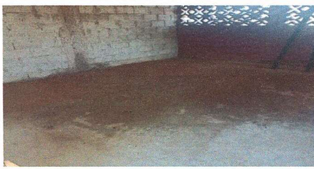
Foto 4: SE OBSERVA LA ESTRUCTURA DEL MODULO 2.
